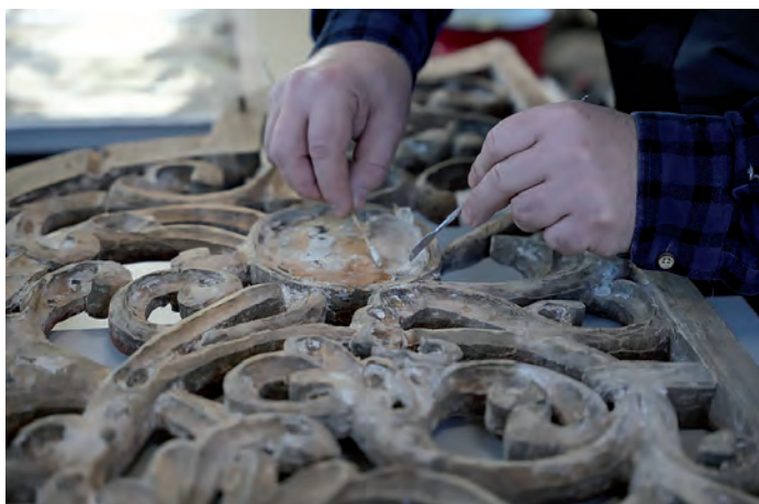
Usuwanie tymczasowych zabezpieczeń, fot. Jakub Piasecki
