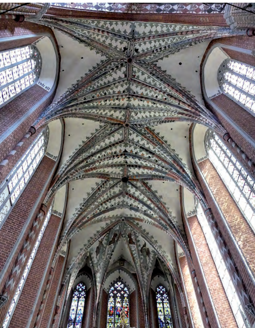
Fot. 2. Sklepienie prezbiterium
