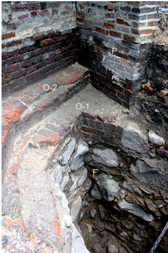
Fot. 6. Fundament prezbiterium – przestawiona przypora; ściana północna
