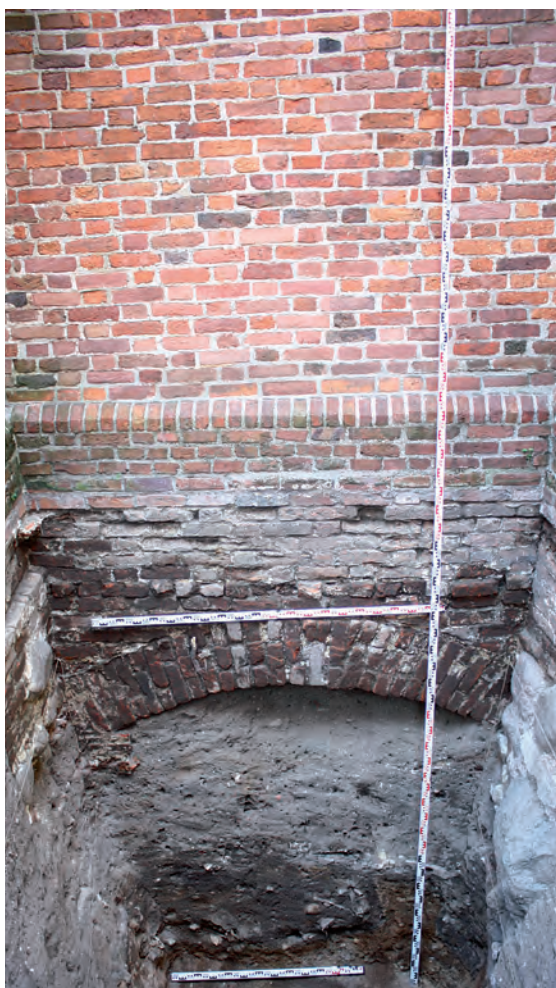
Fot. 8. Arkadowy fundament pod kaplicą
