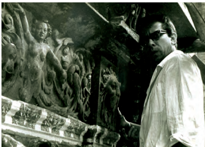
Portal Pałacu Eskenów w Toruniu — strukturalne nasycanie kamienia metodą kieszeniową (celofan, gips) Fot. Archiwum Profesora
